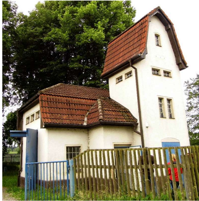
Quelle: Stephan Schwarzbald Pumpenhaus Murschnitz No.22, Chemnitz-Wittgensdorf
