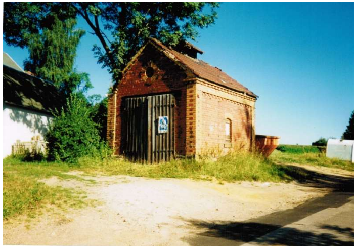
Spritzenhaus vor dem Abbruch
