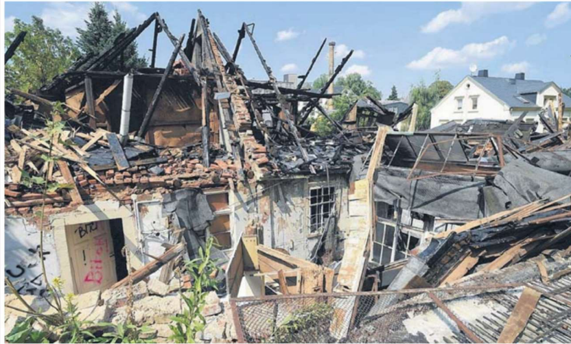
Am Tag nach dem Feuer steht nur noch das Gerippe des Hauses, in dem sich bis 1972 ein beliebter Gasthof befand.
